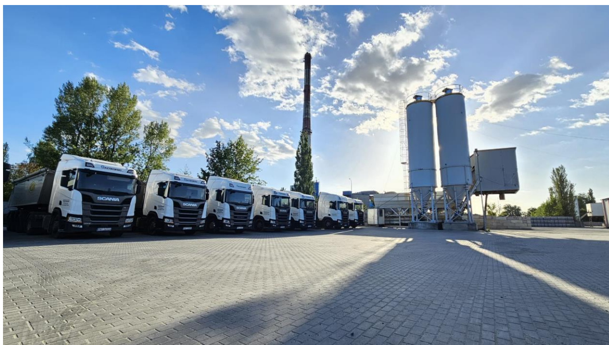
Rysunek 3.1: Zakład Betoniarsko-Budowlany Andrzej Grzybowski
